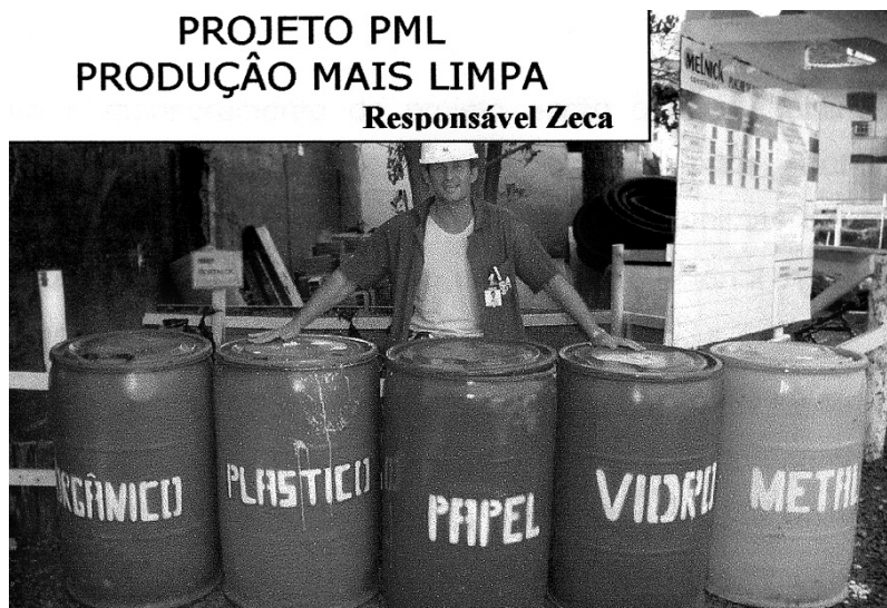
Figura 2 – Tonéis de segregação de resíduos implantado em outra obra da Construtora Melnick com o padrinho da obra.
