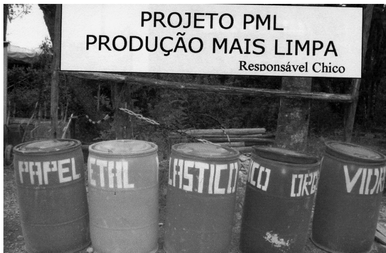
Figura 1 – Tonéis de segregação de resíduos implantados em obras da Construtora Melnick para operacionalização do programa de produção mais limpa (PML).
