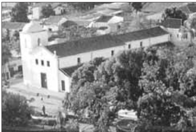
Figura 2 – Telhado da Igreja de Nossa Senhora do Rosário - São Benedito.
