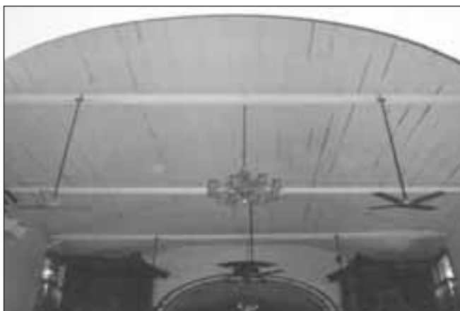
Figura 3 – Forro da Igreja de Nossa Senhora do Rosário - São Benedito.
