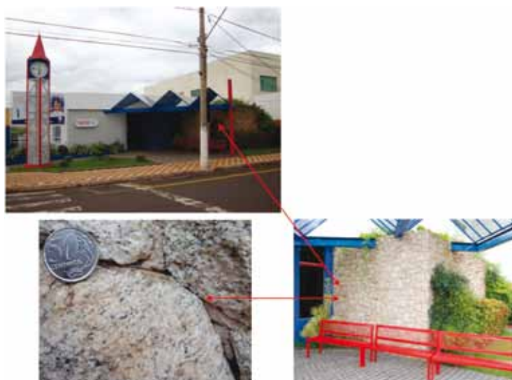
Figura 7 – Escola de Idiomas Cultura Inglesa. Fonte: Guilherme Valagna Pelisson (2010)
