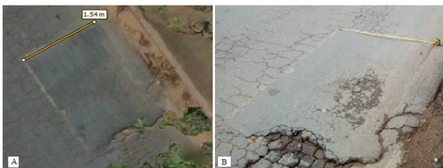
Figura 8 - Levantamento de manifestação patológica tipo remendo: em (A) vista na imagem, em (B) na fotografia in loco
