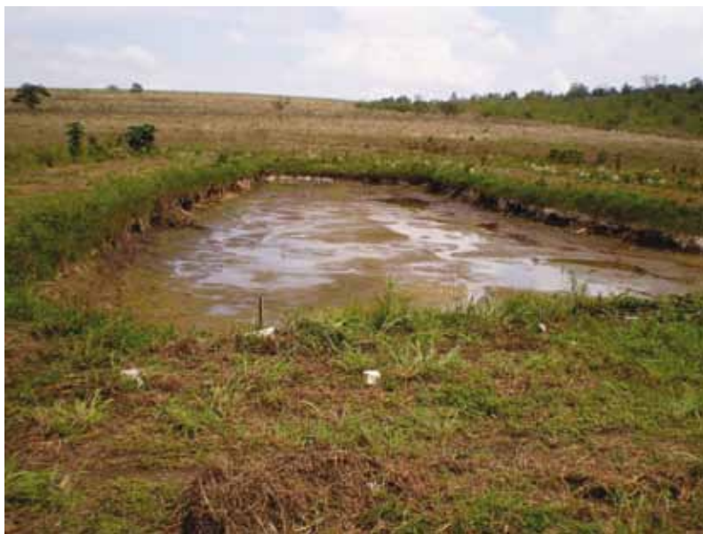
Figura 5 – Baixa infiltração de água nos tanques.
