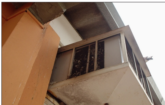
Figura 10 – Ar condicionado do bloco de Saúde
