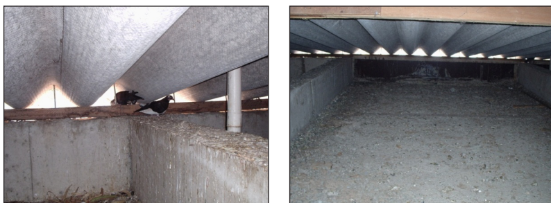
Figura 7 – Forro do Bloco de Saúde I.
